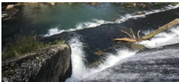
Figure 4 : Vue du mur bétonné en rive gauche du seuil
