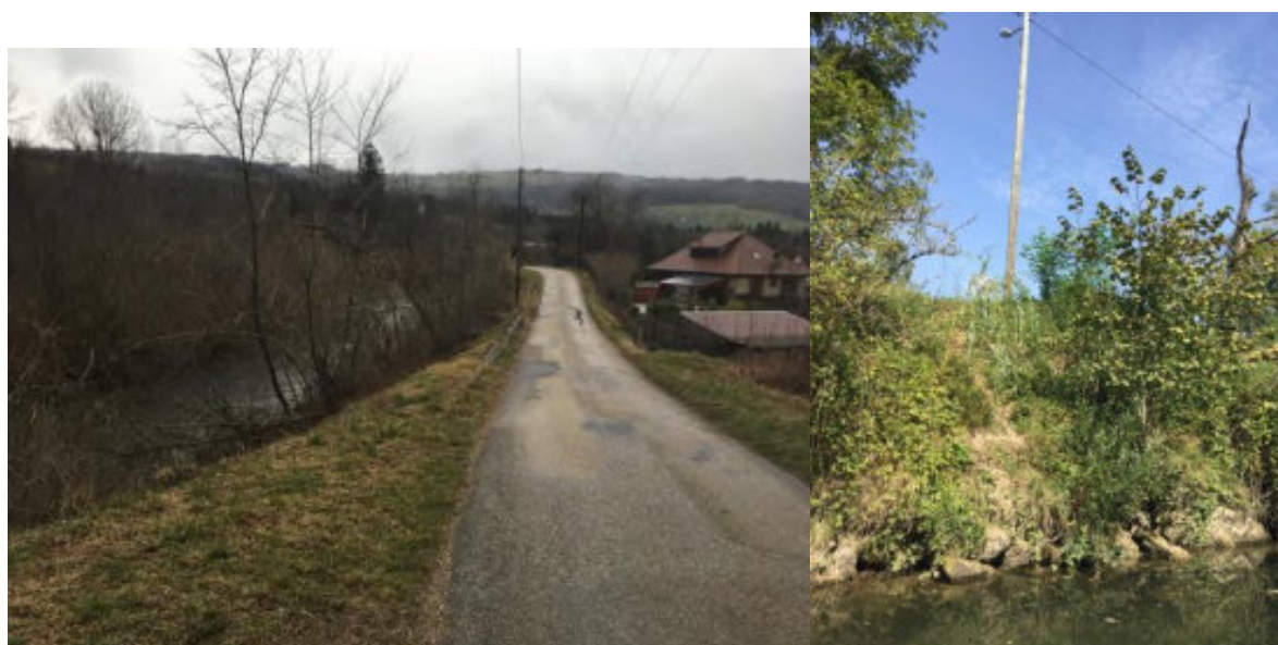
Figure 42 : Vues depuis le haut et le bas de la digue du Suiffet
