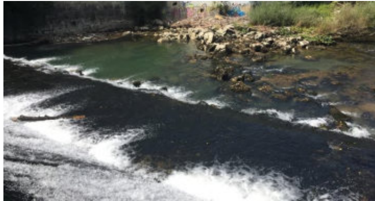
Figure 5 : Vue des enrochements saillants au niveau de la deuxième chute
