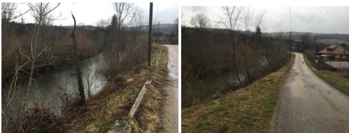
Figure 23 : Vue depuis le chemin de la Broue en tête de digue
